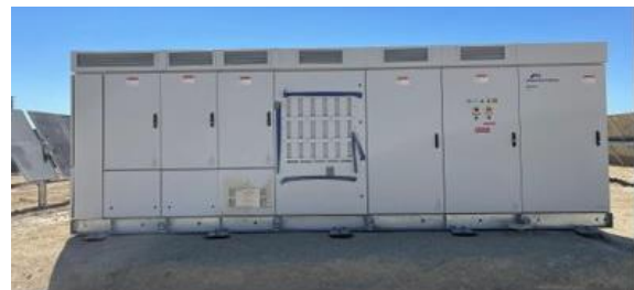
Ejemplo de un PCS sin cadenas de seguridad rojas instaladas:
